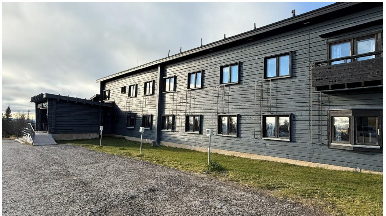
Julkisivu etelään. Aukotus ja detaljiikka on säilynyt alkuperäisenä. Häätäpoistumisen tikapuiden malli vaihtunut.
