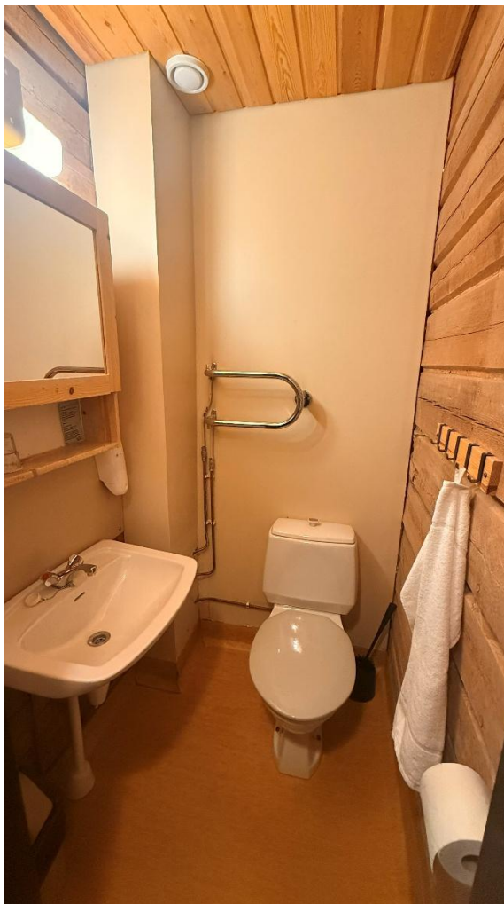
Vanhan hirsiosan huoneen wc. Wc:t tehtiin 1988 toteutetun laajennuksen yhteydessä.
