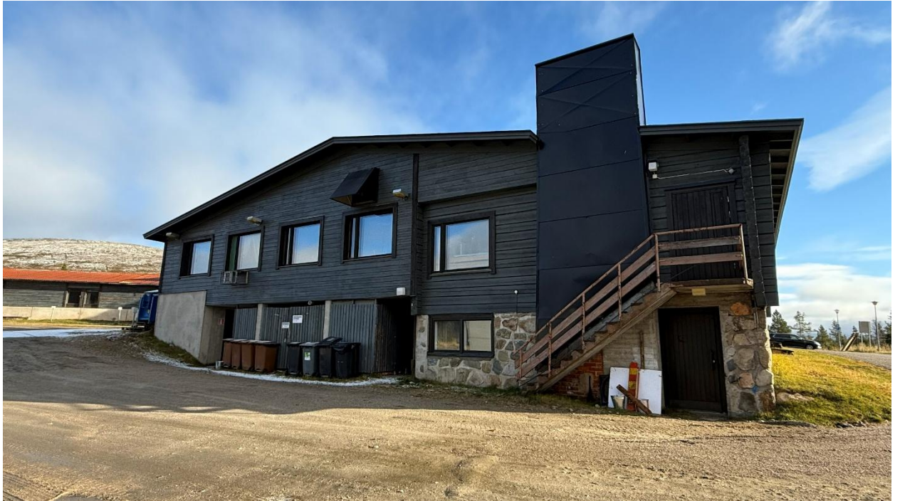
Päädyn kivetty sokkeliosa näyttää 1961 tehdyn ravintolan laajennusosan. 1988 päätyä laajennettiin ja runkosyvyyttä kasvatettiin keittiömuutoksen vuoksi.
