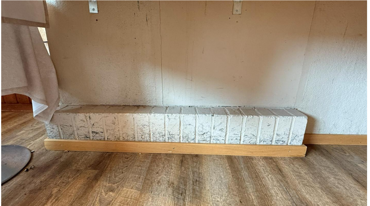
Laajennuksen takka/palomuuuri. Takka muurattu umpeen.
