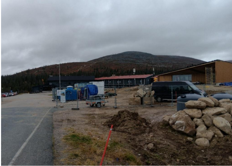
Kuva 4. Oikeassa reunassa valmistuva Pallastunturin lähtöportti. Taustalla Laukukeron kulumisen jäljet näkyvät kauas.
