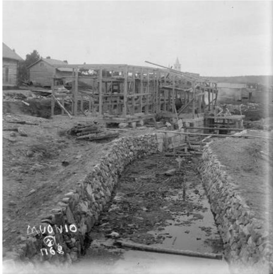
Kuva 1. Myllypaikka 1920-luvulla, jokiuoma oli kivetty kanavaksi, rakenteilla olevan myllyn ja sillan kohdalla oli käytetty hakattua kiveä. Myllyn ja sähkölaitoksen lisäksi Jerisjoki toimi uittoreittinä. Taustalla kirkon torni.
