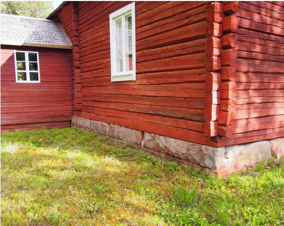
Kuva: Museoalueen siirretty rakennus, kivijalka ja betonisokkeli
