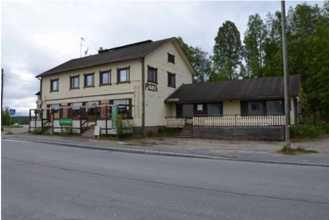
Kuva: Entinen osuuskauppa 1950-luku, oikealla nuorempi laajennus.
