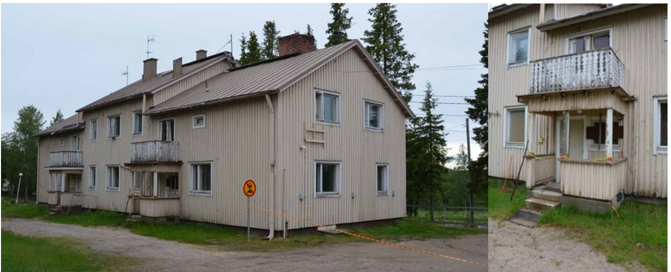
Kuvat: Vasemmalla opettajien asuntolaa koillisesta lounaaseen päin. Oikealla detaljikuvassa pihan puolen sisäänkäynnin avokuisti, jonka päällä on yläkerran parveke.
