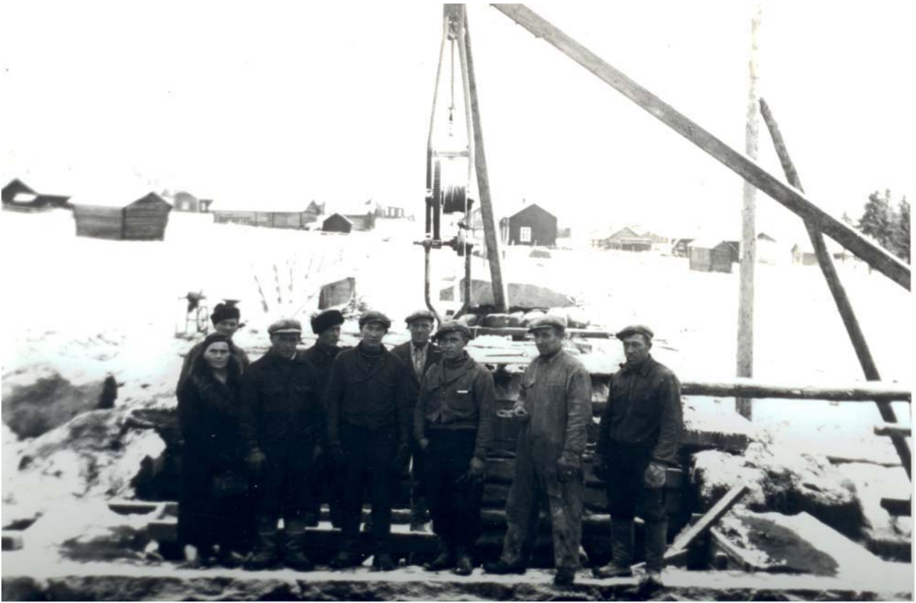
Myllyojan siltatyömaa Ylimuoniossa. Asiasanat: sillat : työmaat : Ylimuonio : Muonio
