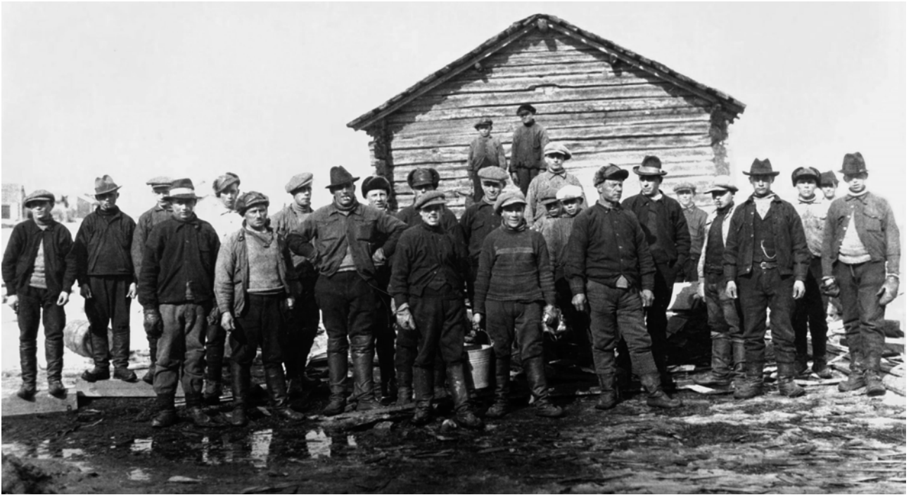
Kansakoulun lisärakennuksen kattopäreiden punausporukkaa vuodelta 1928.
