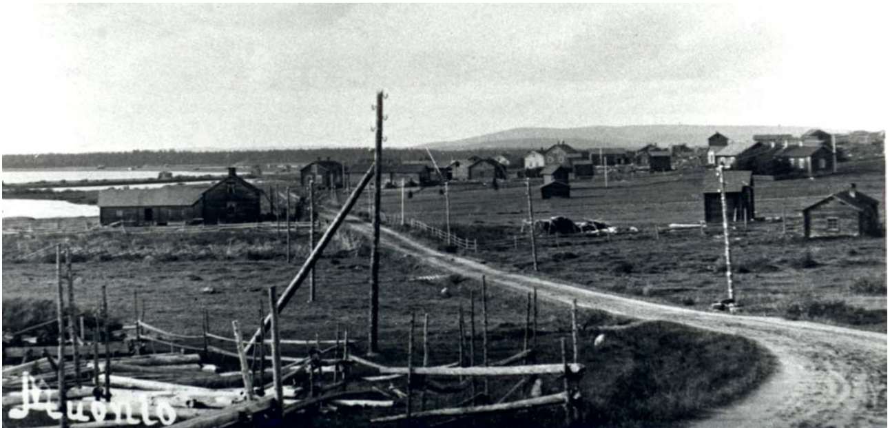
Näkymä Rautiontörmältä pohjoiseen. Vasemmalla August Brännaren talo ja oikealla Samuel Anttilan talo.
