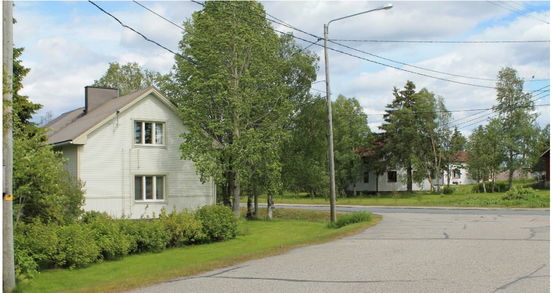
Kuva 14. Perinteistä rakennuskantaa Lahenrannantien varrelta (FCG / Mari Lampinen)
